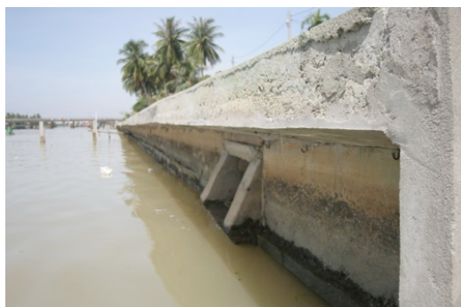
ホイアンの下水溝の排出口
