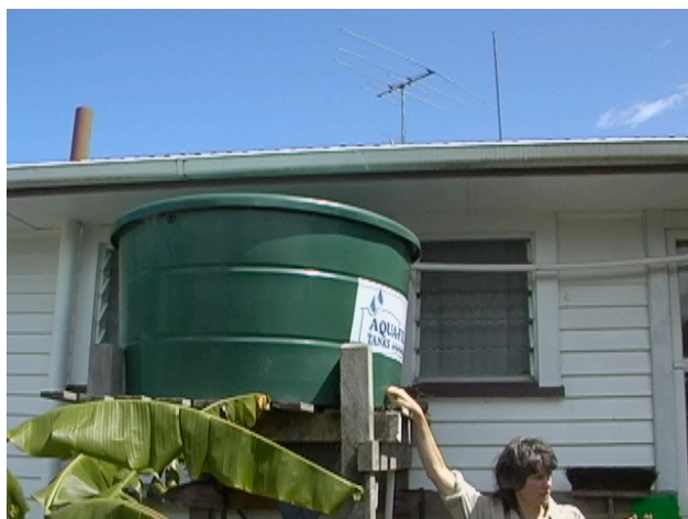
ニュージーランドでの雨水利用の例（洗濯用に使用 1t）
