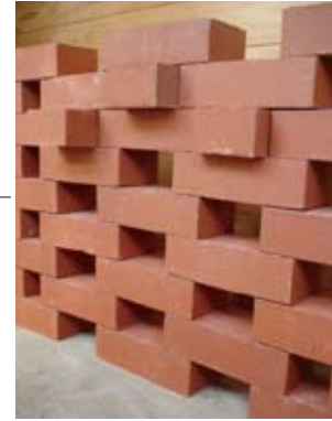
外壁：通常埋設してしまうレンガを露し仕上げとしてデザイン
